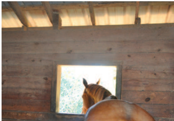
L'espace entre les parois et la toiture permet une bonne ventilation naturelle.
