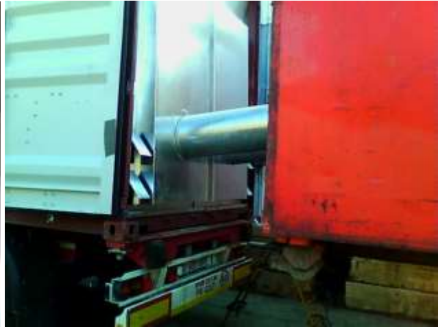
Figure 6 : parois d'échanges installées sur le conteneur, on voit les volets d'extractions sur le côté.
