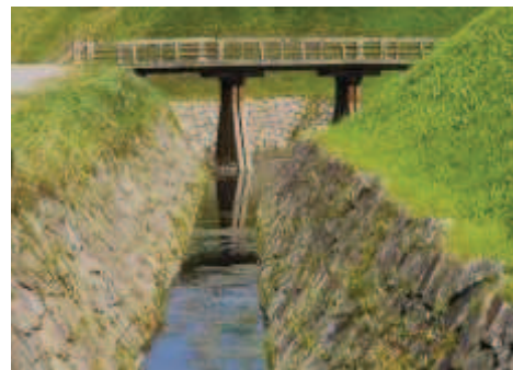
Un fossé maçonné sur le terrain
