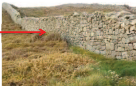
Le même mur, vu sur le terrain
