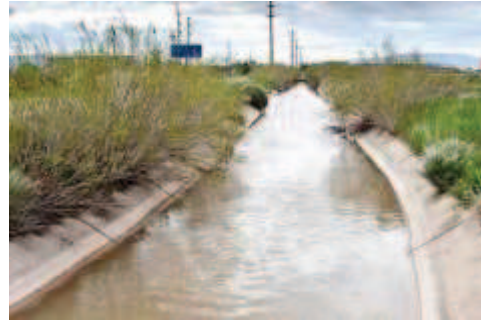
Un fossé maçonné sur le terrain
