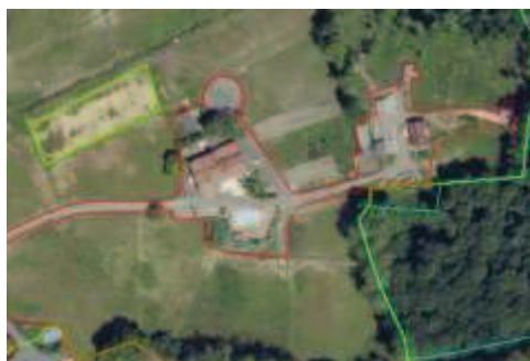
Surface aménagée regroupant bâtiments et route d'accès
