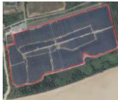
Panneaux photovoltaïques : numérisation de la ou des zones d'implantation si densité de panneaux supérieure à 30 % de la surface Sinon : numérisation séparée de chaque rangée de panneaux
