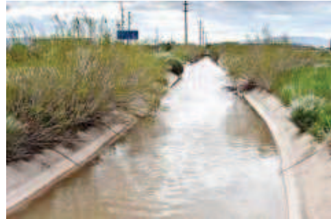
Un fossé maçonné sur le terrain
