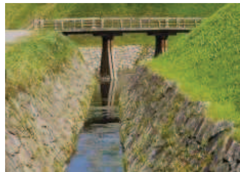
Un fossé maçonné sur le terrain
