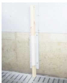
Bois fixé au mur
